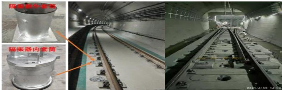
2) 预制式钢弹簧浮置板：区别于现浇浮置减振道床，预制式钢弹簧浮置板在施工现场之外的工厂预先生成混凝土轨道板，整板运抵项目现场后，采用铺板机快速铺设，开启了“环保、绿色、高效、低碳”建造高质量、高效率、高性能的隔振轨道工程模式，大幅度提升了轨道工程预制装配化率，提高了隔振轨道的施工效率和工程质量，不仅节约了劳动力成本、而且减少了施工现场的环境污染，获得中环协环境技术进步一等奖。
