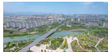
宁夏固原市海绵城市建设 PPP 项目
