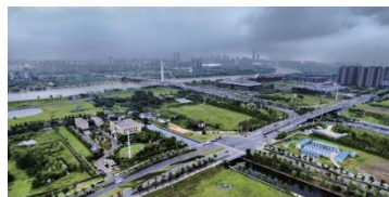
南京江心洲生态科技岛海绵城市项目
