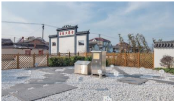
泰州姜堰区镇村污水处理工程 PPP 项目
