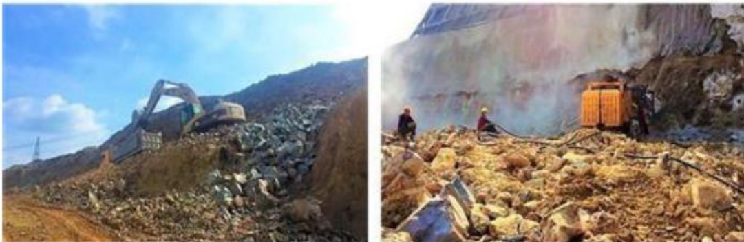
土石方开挖施工
