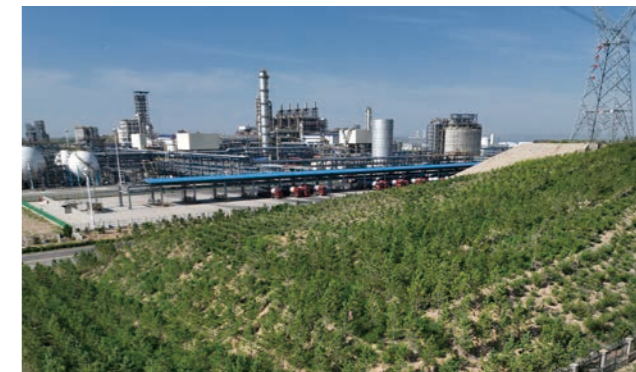
厂区绿化照片
