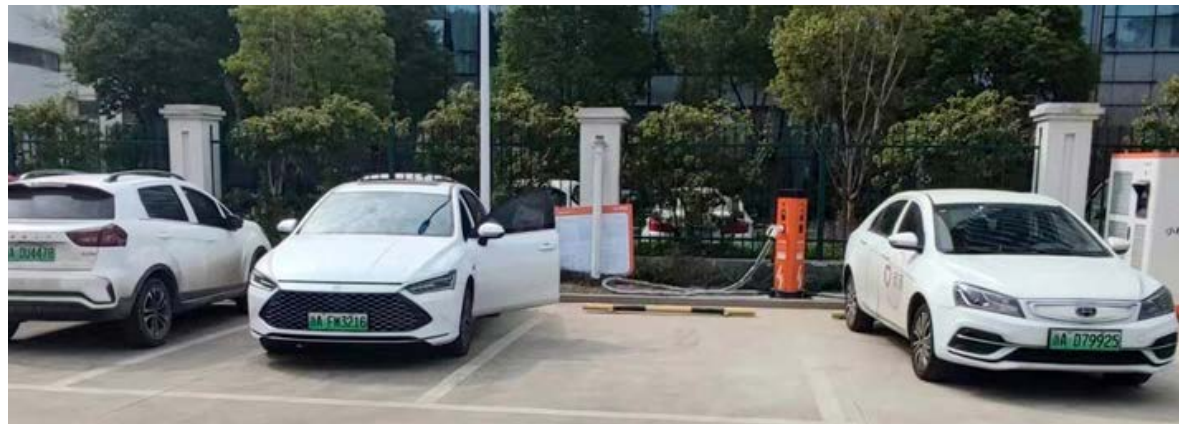
充电桩配套设施
