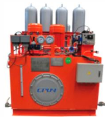
水电站进水蝶阀液压系统
