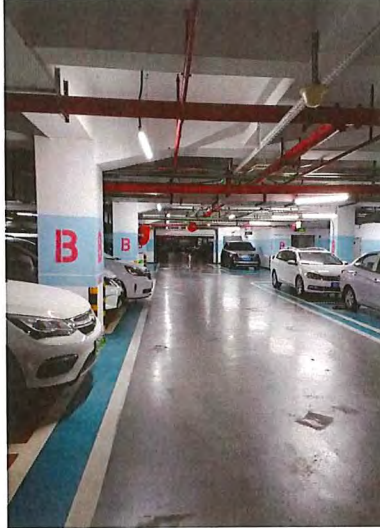
地下室停车位
