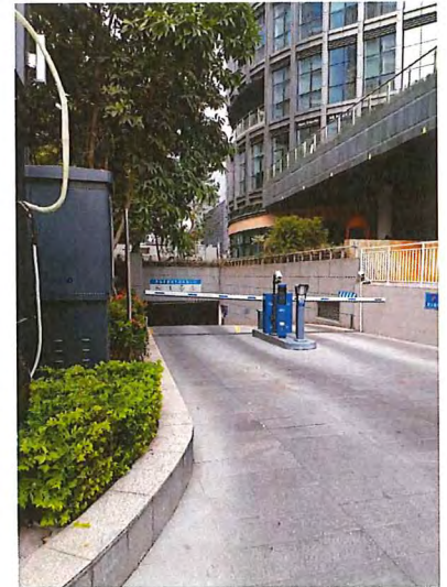
地下室出入口
