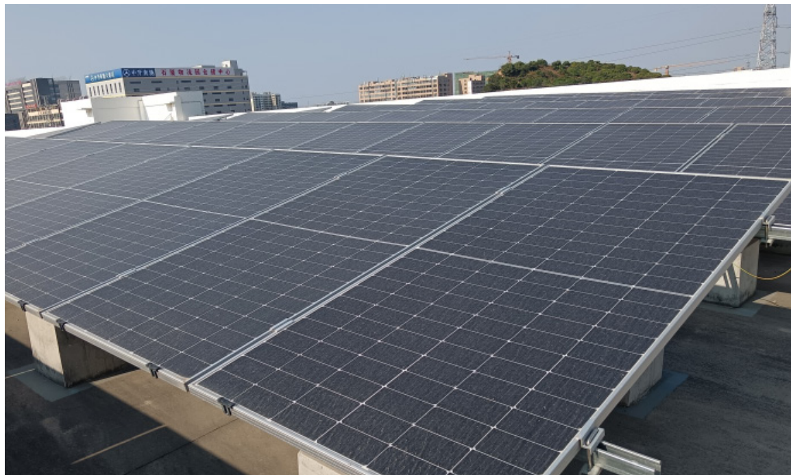
▲ 天虹东莞物流园区一期项目
