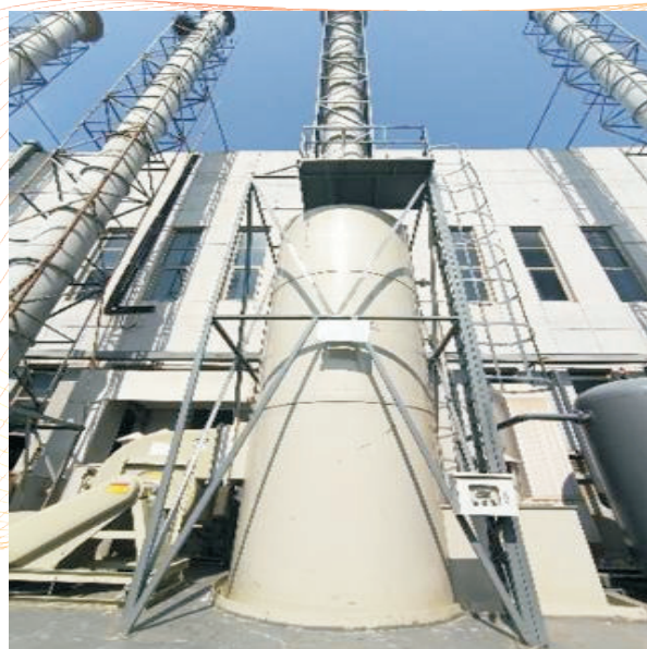
酸碱废气喷淋塔更换
