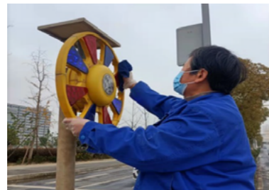
武汉天马采用太阳能回转灯 LED 红蓝警示灯替代传统警示灯，实现清洁能源在安全方面的推广应用
