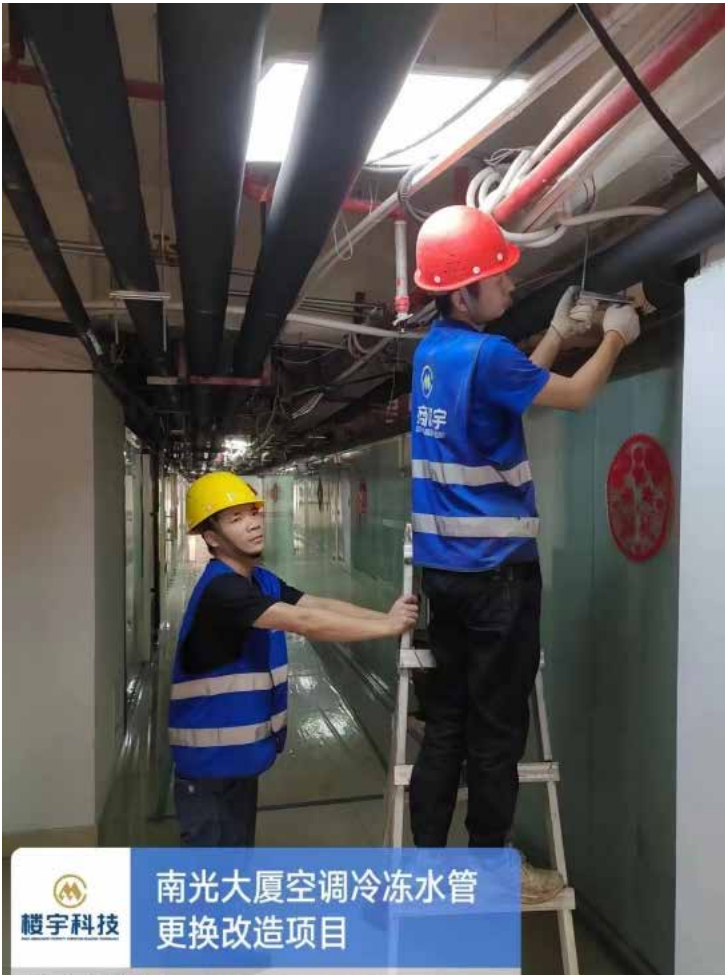
南光大厦空调冷冻水管更换改造项目
