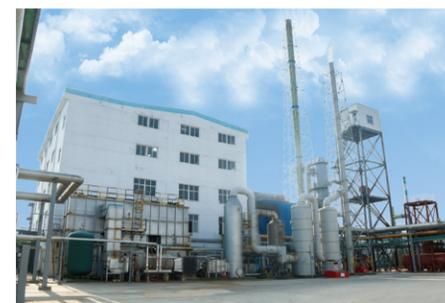
RTO蓄热式废气焚烧处理装置
