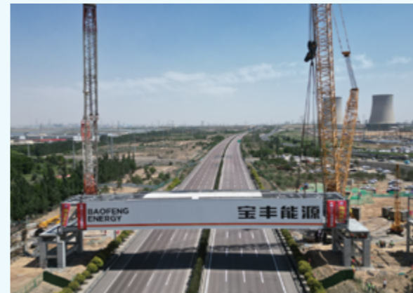
国内最大 跨度的三通道平面曲线钢栈桥完成吊装
