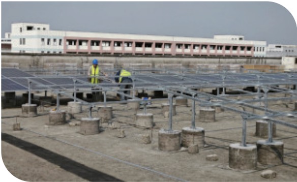
◆ 施工人员在安装光伏板
