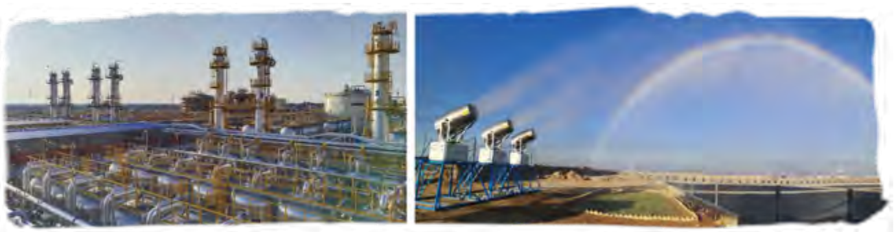
米桑油田终端厂水处理区域
