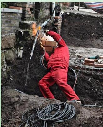
重庆公司对 283 个小区约 23420 户的燃气设备设施进行改造，包括庭院中、低压管道、用气附属设施、引入管、立管、燃气表更换、户内管道改造、安全装置加装及更换燃气器具连接波纹管等。
