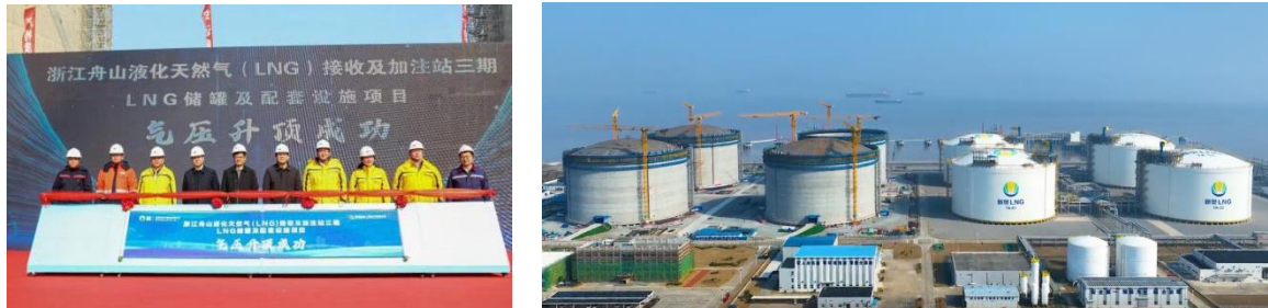
舟山接收站三期四座新增储罐气压升顶成功
