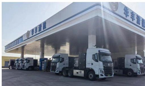
华丰加氢综合能源服务区项目
