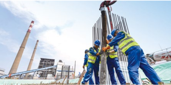
河北陡河热公司两台66万千瓦供热机组基建项目
