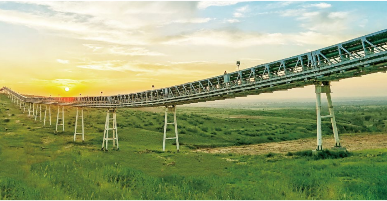
内蒙古托克托发电公司开展圪圖免沟项目利用管道式运输机将托电所产粉煤灰密闭输送至圪圖免沟小流域进行贮存和生态治理，开创了国内利用粉煤灰进行小流域综合治理的先例
