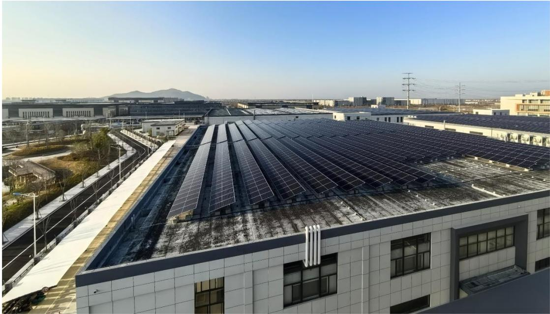
图一：募投项目厂房屋顶所配备的光伏发电系统
