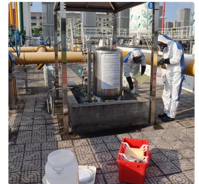
公司开展场站加臭装置泄漏专项演练
