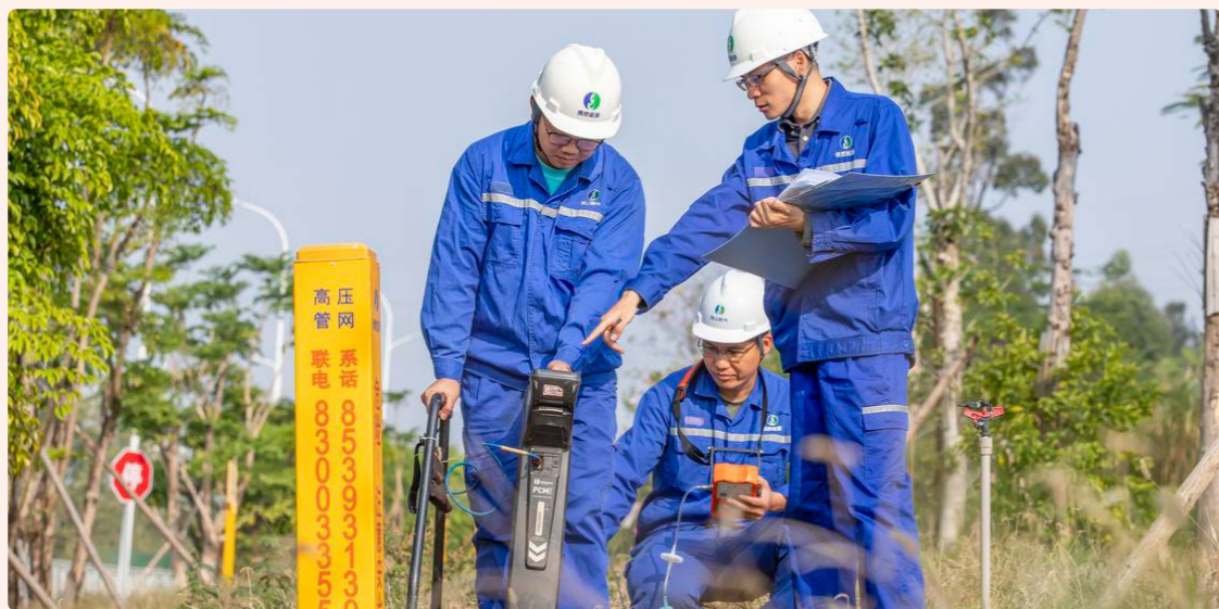
及时排查管道问题、业务员对问题点检查监控
