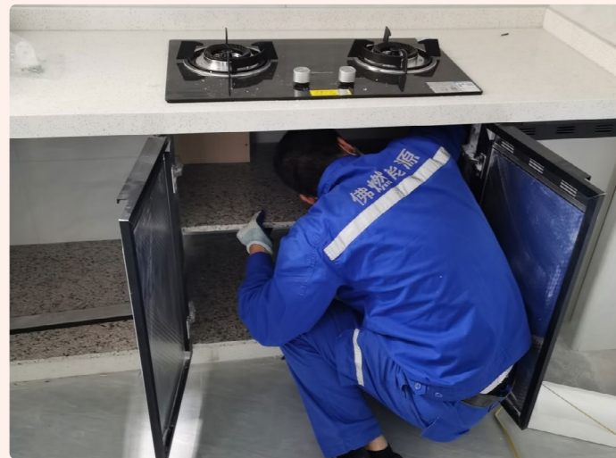
五社村燃气配套管道建设工作
