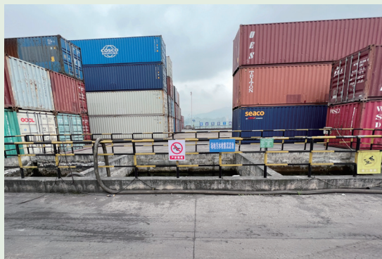
► 集装箱堆场沉淀池收集循环系统
