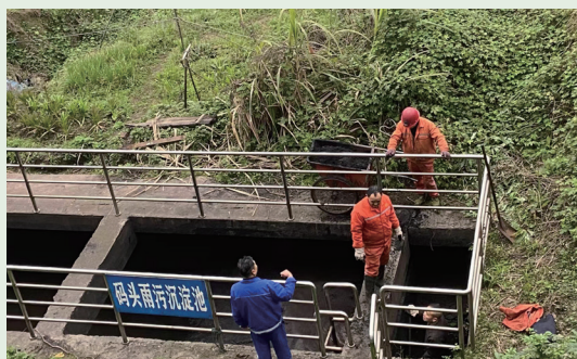
► 江津分公司清掏沉淀池
