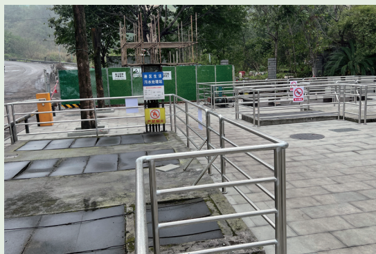
► 生活污水处理站处理循环系统
