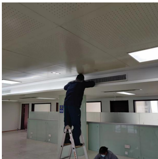
施工人员更换节能灯具
