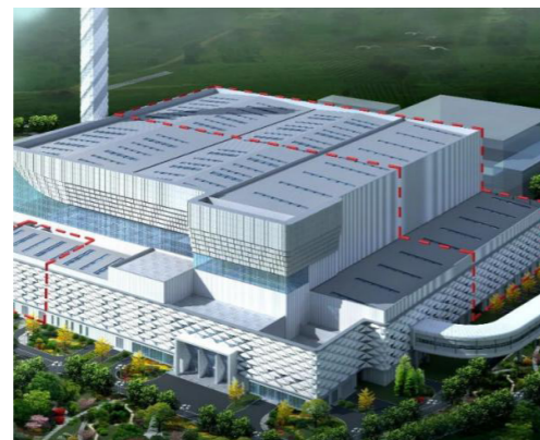
千子山循环经济产业园
