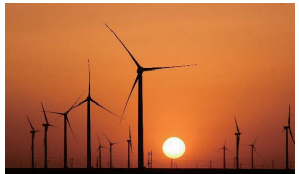
◆ 本行支持的瓜州市(县)某10万千瓦工程项目已投入使用
