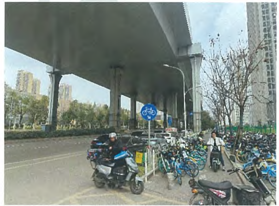
西临光谷大道
