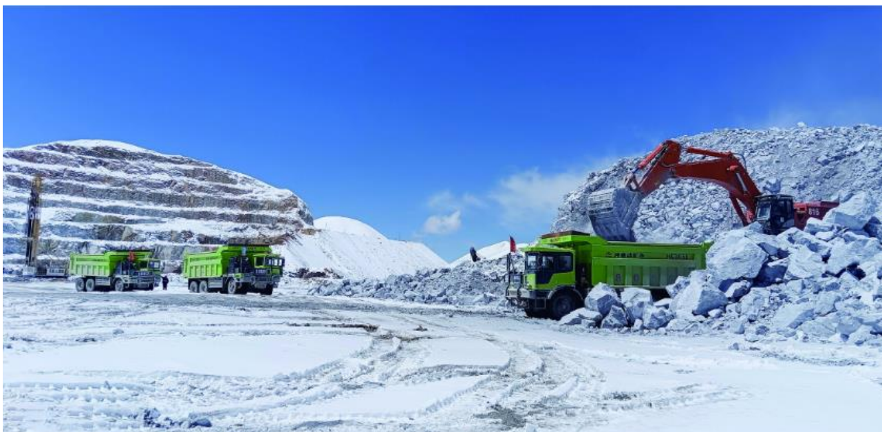
图四 巨龙铜矿露天采剥工程
