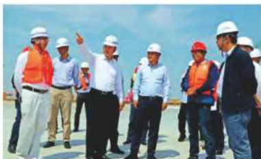
6月8日，集团党委书记、董事长顾金山到罗泾港区集装箱码头改造一期项目现场调研。
