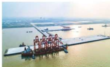
10月15日，罗泾港区集装箱码头改造一期工程首批大型装卸设备顺利到岸。
