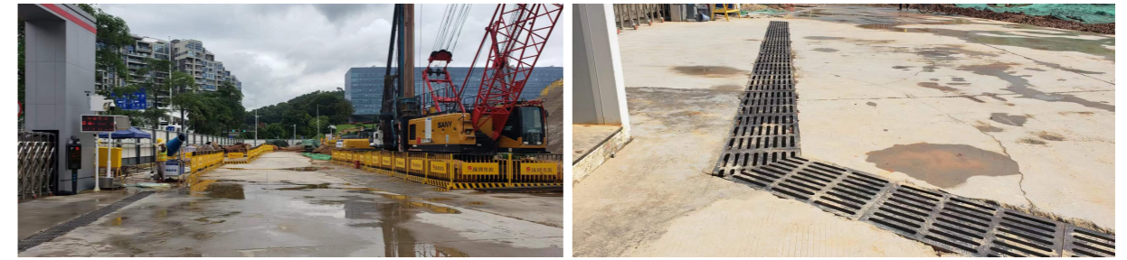
道路两旁雨水排水沟系统
