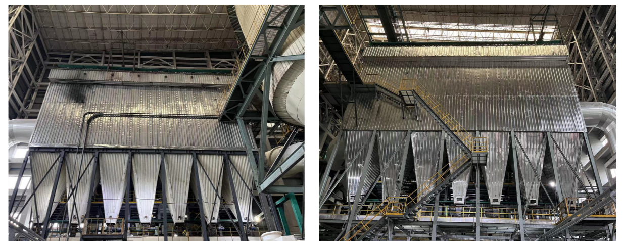
改造完成后的布袋除尘器
