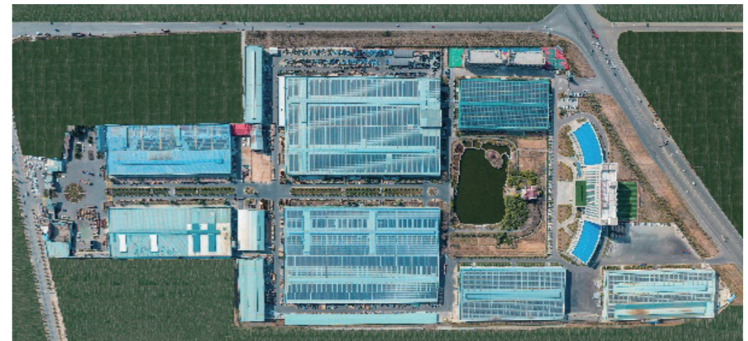
公司厂房安装屋顶光伏
