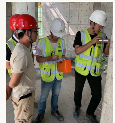
施工检查：利用“移动”验房系统进行“四全”检查
