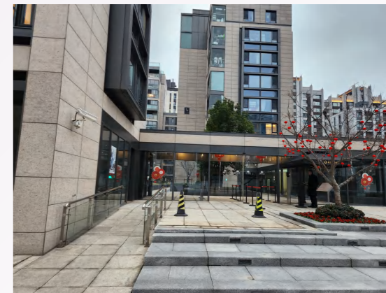
上海浦江海德内部人行横道设为缓坡
