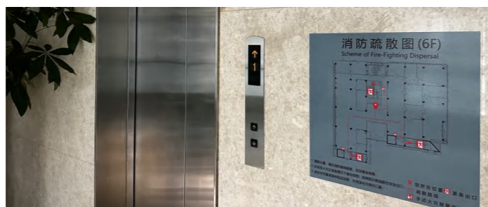
办公楼电梯口张贴消防疏散图
