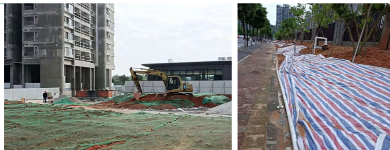
绿化前临时覆盖绿网 彩布条临时覆盖防止水土流失
