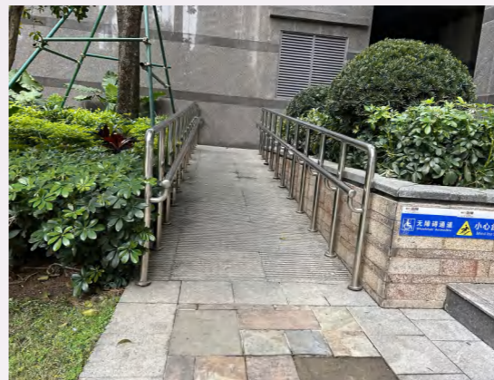
格力香樟入口处设立无障碍通道
