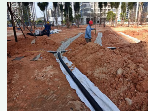
◉ 海绵城市滤水管铺设
