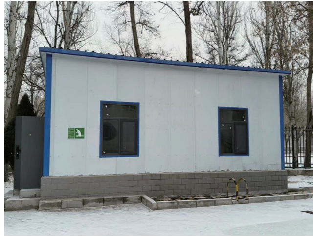
工业废水在线监测站房
