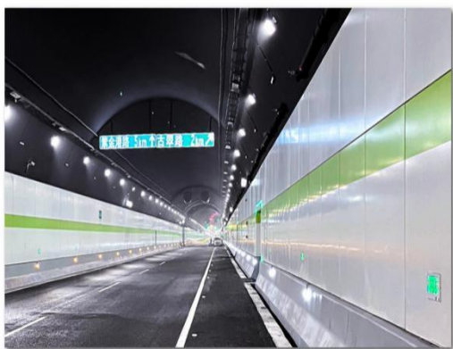
杭州天目山路隧道
