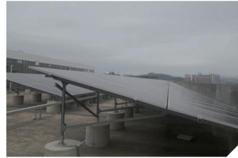
光伏设备的安装充分利用工厂楼顶的闲置空间，通过太阳能的转化，为工厂提供了绿色电能。这些电能被直接用于工厂的恒温电子仓，确保仓内电子产品的稳定存储和高效运行。此外，光伏电能的使用减少了工厂的碳排放量，为缓解全球气候变暖做出了积极贡献。朗科科技的这一环保行动，不仅提升了公司的社会形象，更为其他企业树立了绿色生产的典范。
