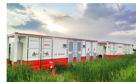
燃气发电 + 全电驱压裂拉链式作业
