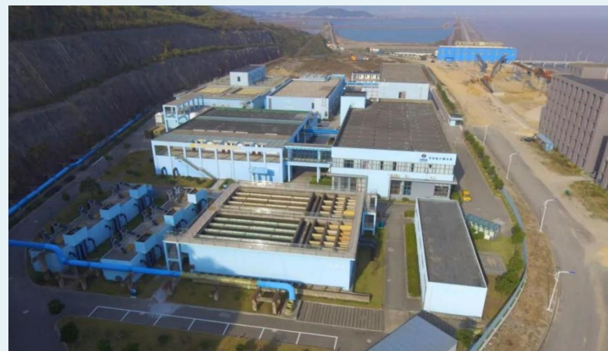
碧水源山东鲁北海水淡化工程
