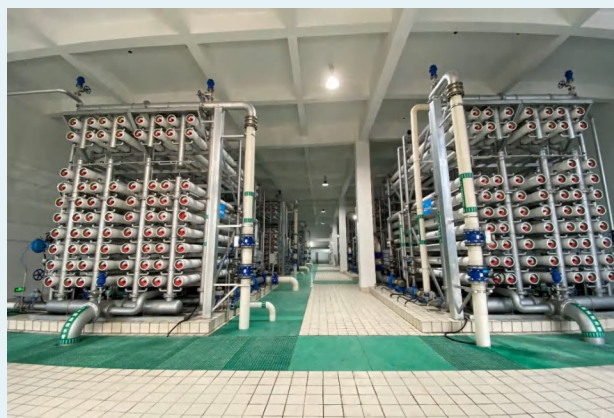
江苏太仓市第二水厂深度处理工程
