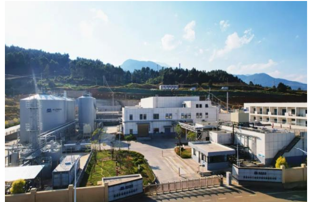
西昌餐厨垃圾处理厂项目
