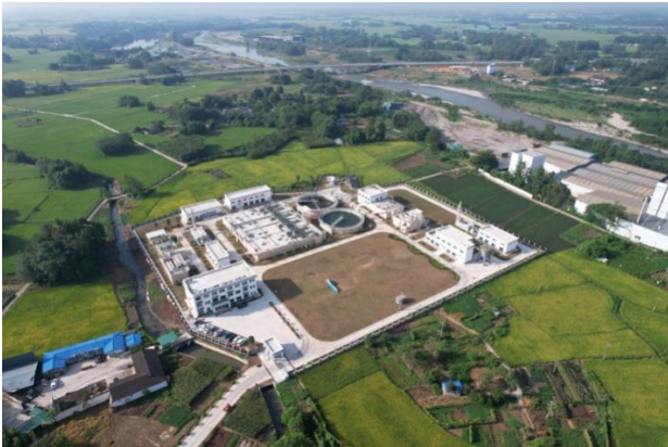
大邑县安仁污水处理厂项目顺利完成竣工验收
