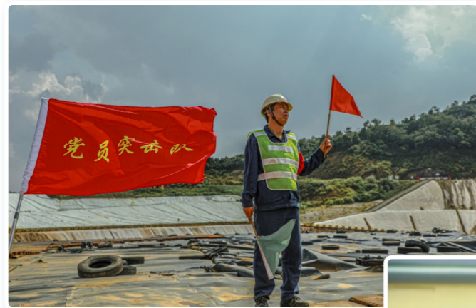
党员突击队正在进行灰飞填埋作业
