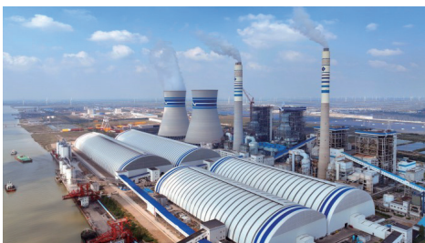
射阳港电厂 1000MW 二次再热超超临界燃煤发电机组投产
