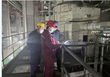
苏晋保德 开展“迎峰度夏”安全检查
