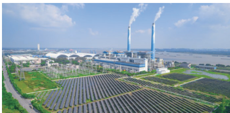
国信扬电厂区 21MW 分布式光伏发电项目
