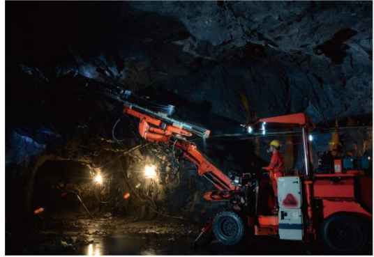
使用井下高效开采设备
