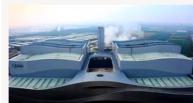
康恒环境杭州临江垃圾发电项目
