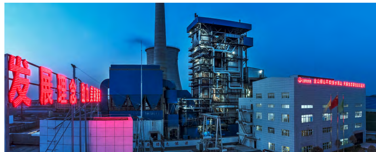
天壕新能源漯河项目生物质流化床锅炉
