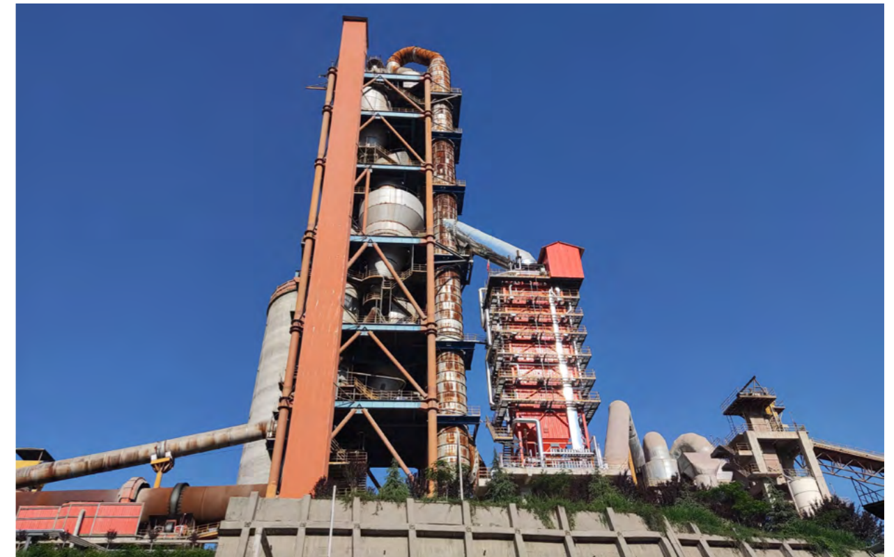
天水天祥水泥余热发电项目顺利并网发电，预计年平均发电量约3.68×10 7 千瓦时，每年节省标准煤10776吨，减少二氧化碳排放约29876.5吨。
