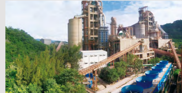
泰国水泥余热发电项目
