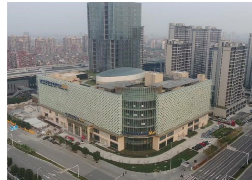
◀ 宁波姚江家居商场 ▼ 屋顶光伏电站
