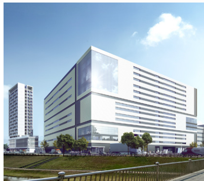
● 光明区数智大厦项目— 光明区“工业上楼”项目
