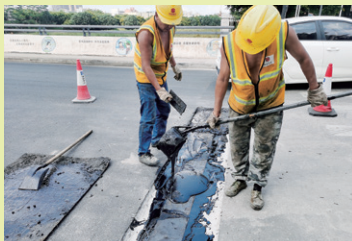
● 采用无缝伸缩缝新工艺，保障路面通畅舒适，减少噪音污染
