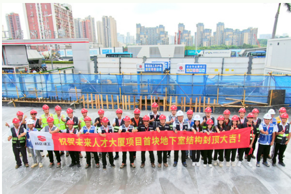
● 未来人才大厦项目首块地下室结构封顶
