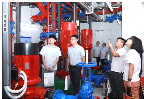
● 消防泵房模块化一体安装施工工程
