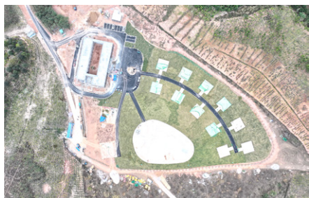
● 龙岗区无人机综合测试基地项目
