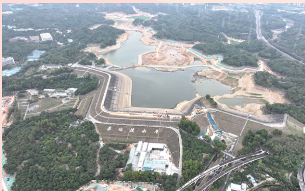
● 长岭皮水库综合治理工程
