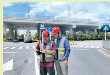
● 使用RTK测量仪调查小修工程，提高工程量准确性
