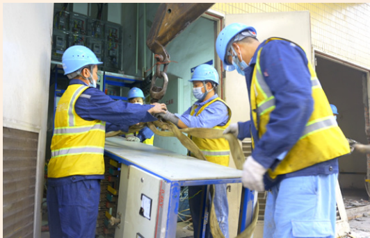
● 转供电项目施工
