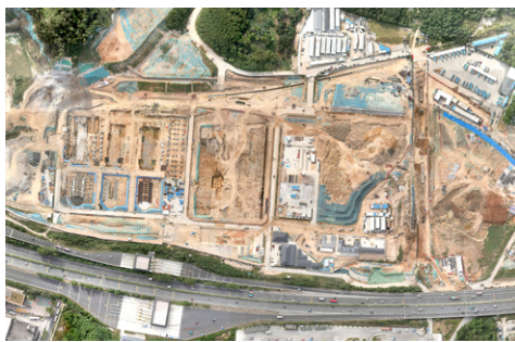
● 深圳能源光明电源基地场平工程
