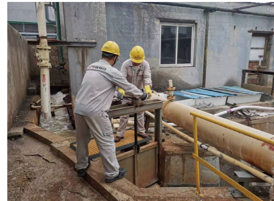
3. 处置小组人员打开应急事故池收集泄漏盐酸。
