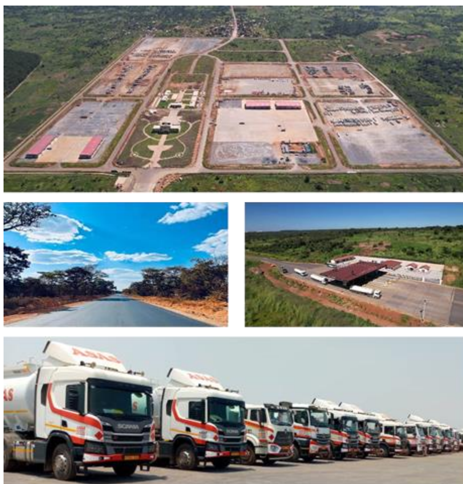
卡萨项目道路及陆港物流基础设施
