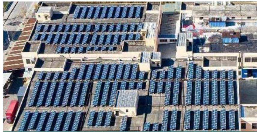
乐歌滨海工厂屋顶光伏发电设施
