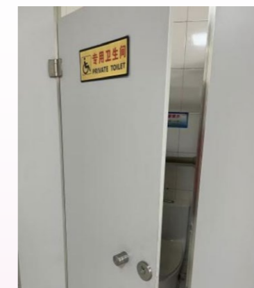
◆ 修建福利人员专用卫生间
