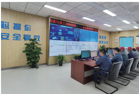
新嘉爱斯电厂控制室大屏
