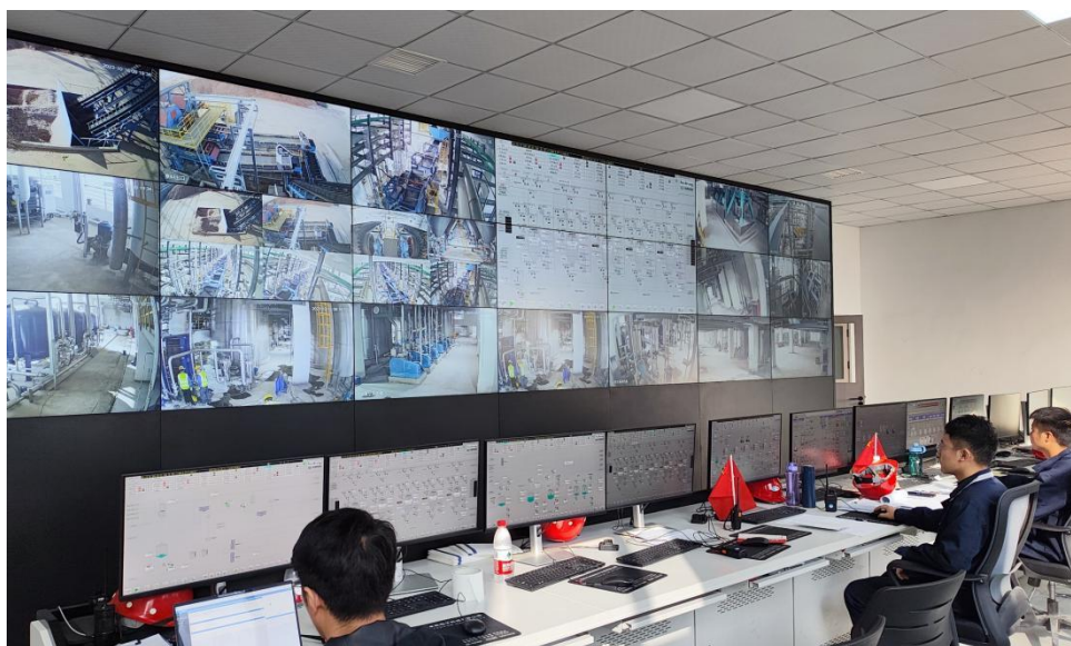
年产 3 万吨 D-木糖绿色智能化提升改造项目主控室
