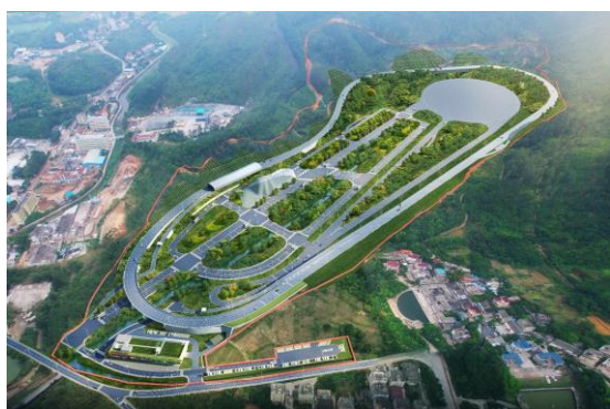
湾区智能网联测试场（坪山）
